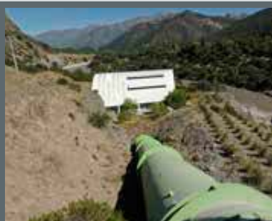
Foto: Juan Carlos Recabal-Revista ELECTRICIDAD.
